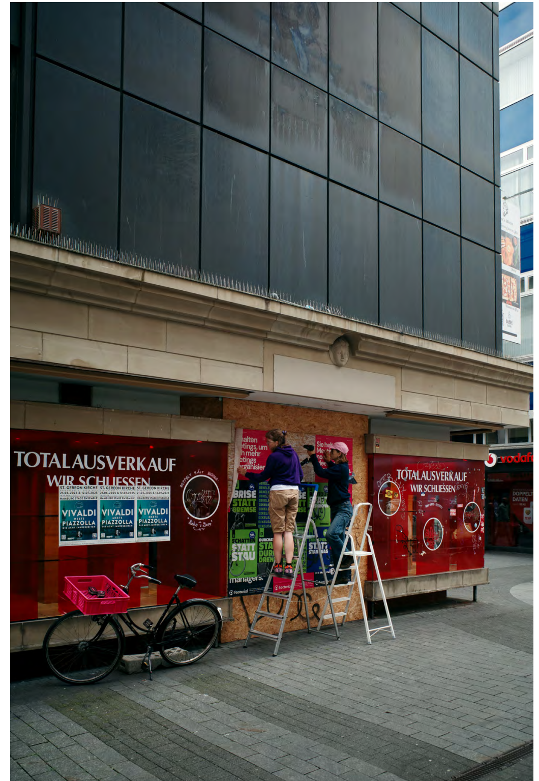
Öffnung der Passage des Ladenlokals in Vorbereitung auf die Summerschool
